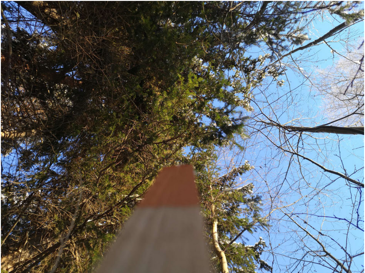
Näkymä kyseiseltä pylväältä ylös.
